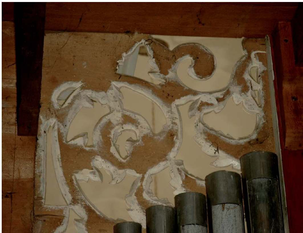
Etten (Gld.), Protestantse kerk, detail snijwerk met houtworm aantasting
